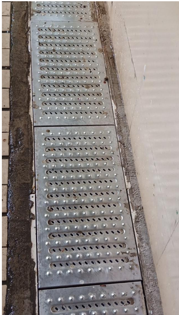
更换后的水沟盖板样式：
