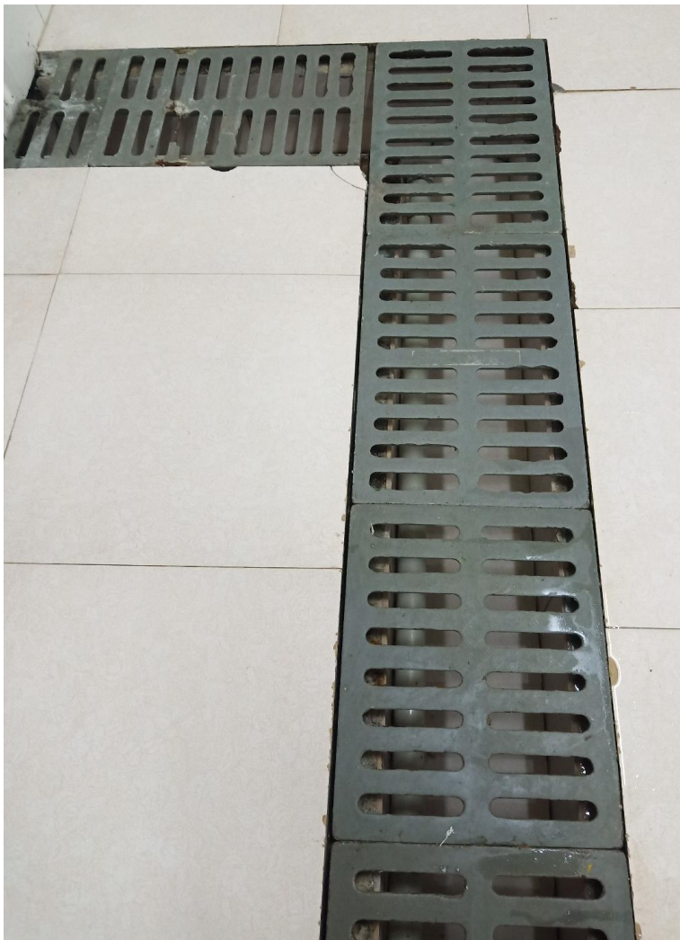
更换前的水沟盖板样式：
